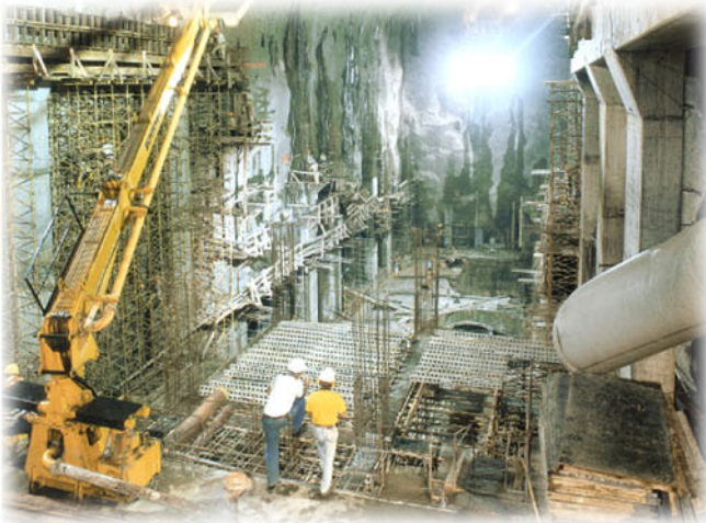
Construcción para la instalación de las turbinas para la presa hidroeléctrica de La Miel de 375 MW en Colombia. Energy International fue responsable por la ingeniería civil, mecánica e eléctrica.
